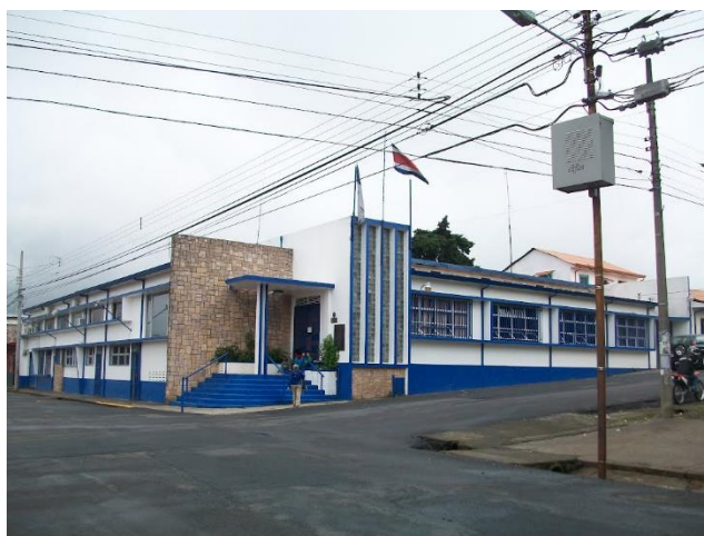
Figura 2. Edificio de la Municipalidad de Santo Domingo de Heredia.
